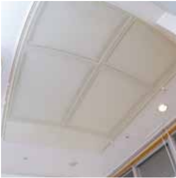
天井部のクリーンエア吸出口
