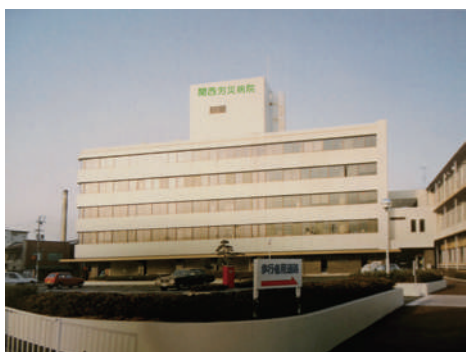
昭和59年 開院30周年当時 病院正面玄関全景
