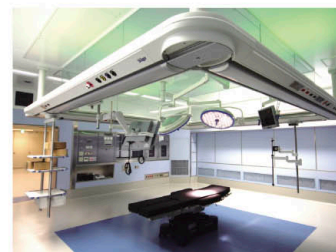
欧州以外では初導入のドレーゲル社オペラ バイオクリーンルーム class100の手術室
