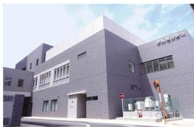
がんセンター外観(延床面積2,038㎡)
